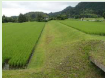
（緩傾斜化された斜面）
