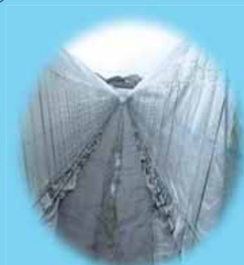
ハウス排水溝の被覆
