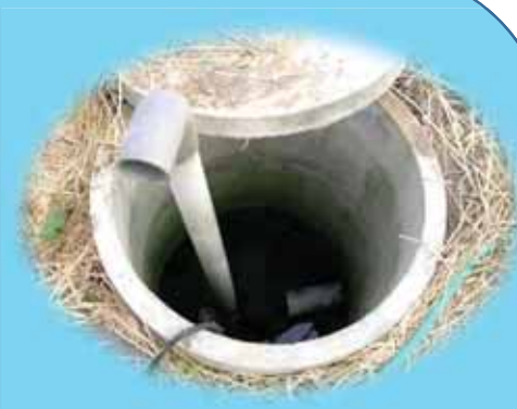
ハウス強制暗渠排水
