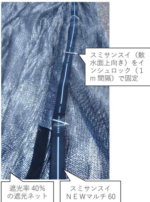
図9 遮光ネットへの散水チューブの取付方法
