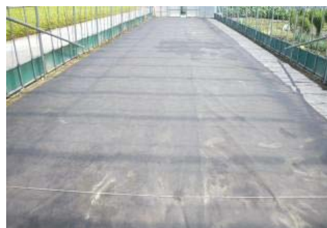
写真2 苗置床への根切シート張り
