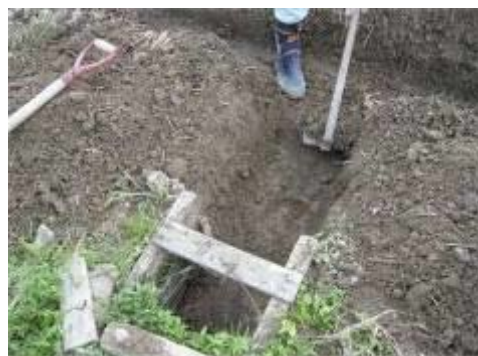
写真 16 排水溝と額縁排水溝、排水口への連結
