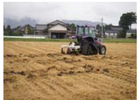
写真 14 弾丸暗渠の施工
