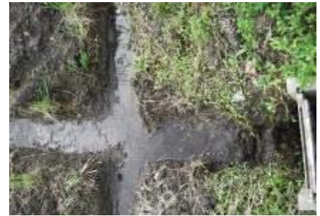
写真 13 額縁排水溝と水尻の連結
