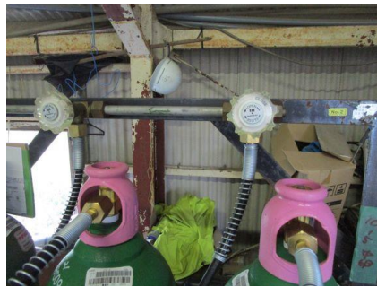
容器弁全閉→圧力計 0→三方弁全閉
