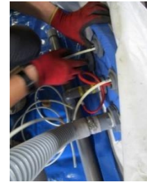
チューブの取り付け （接続ユニット内側）
