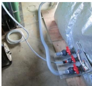
ブロワーの設置と接続ユニット
