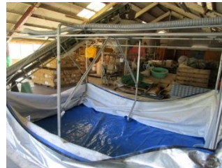
ラック組立完了
