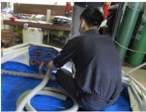
ダクトホースの取り付け （接続ユニット内側）
