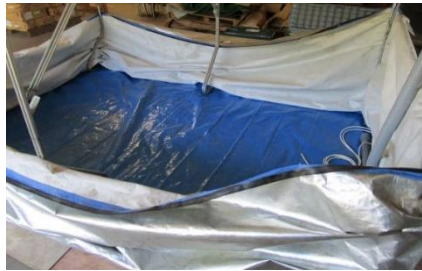
バッグ内にブルーシートを敷く
