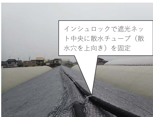
図6 散水チューブ付き遮光ネット
