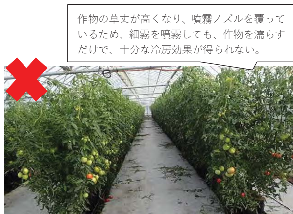
図 12 噴霧ノズルの取付位置が不適切な事例
