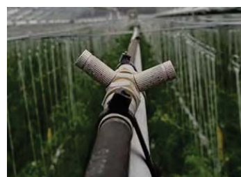
図2 高圧細霧冷房システム
