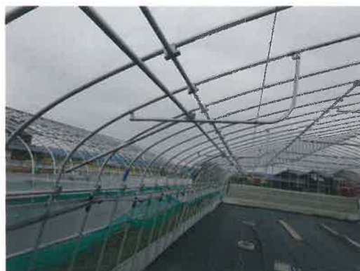
図42 水稲育苗ハウスの側面を利用した簡易棚
