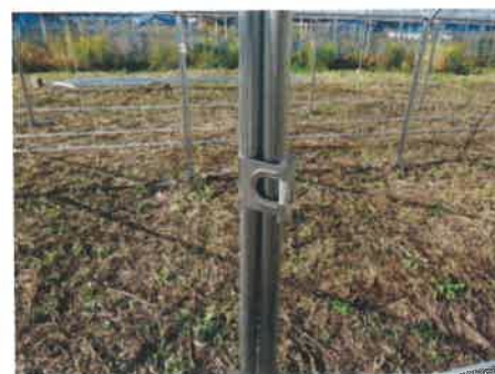
図29 アーチパイプ同士の固定
