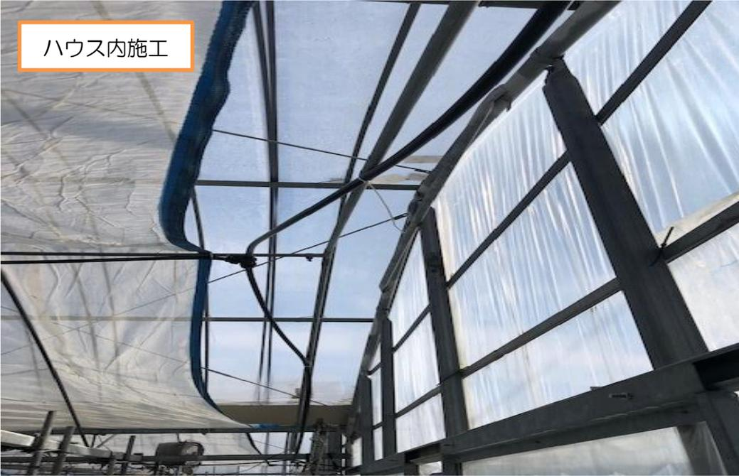
ハウス内のチューブ配置は、内張りパイプの妻面に沿う様に設置しないと、遮光開閉時に邪魔になる。チューブは耐熱性の結束バンドで固定。チューブは真っすぐにカットし、接続部品にきっちり最後までねじ込む。甘いと漏れの原因となる。
