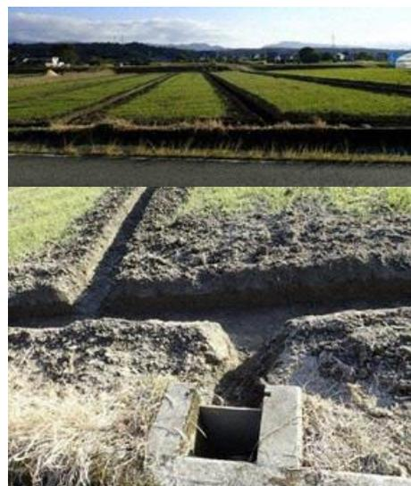
図1 額縁排水溝・基幹排水溝の設置（上）と排水溝への連結（下）
