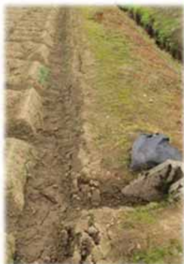
明きょを落水口につなぎ排水
