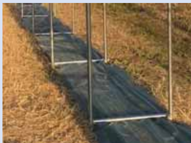
沈下防止対策として、足元 は自在クランプで固定
