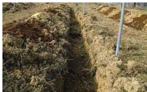
図 5 支柱の横を溝状に掘り上げた事例
