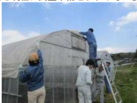
遮熱資材設置の様子
