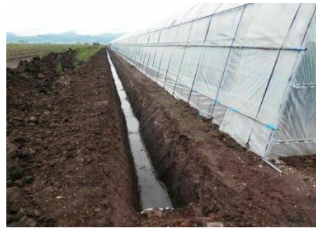
写真2 地下灌漑に基づく対策 （自作した明きよ）
