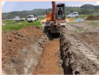
【暗きよの設置状況】
