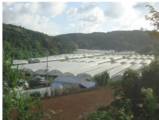
図 ハウス建設後の風景
