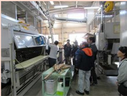
茶工場内の点検
