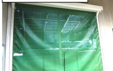
製茶工場出入口の改善
