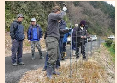
侵入防止柵の設置
