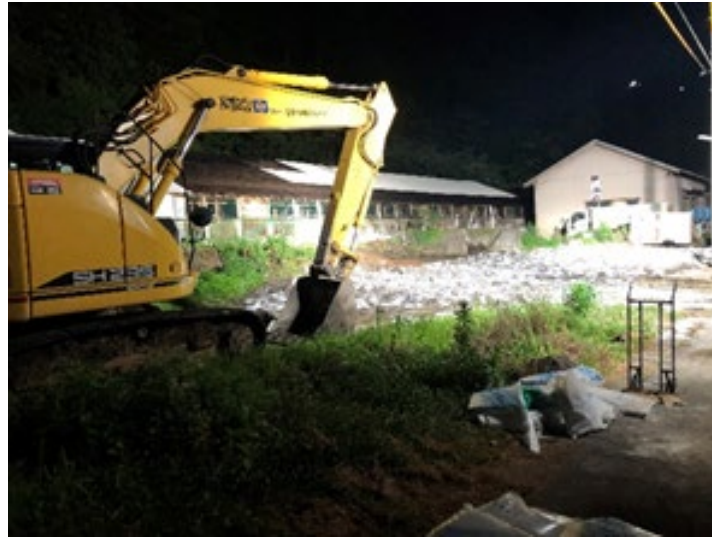
図3 夜間の埋却作業
