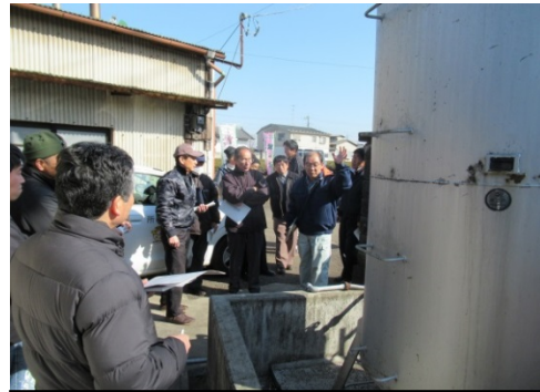
重油タンク・燃料小出槽の点検
