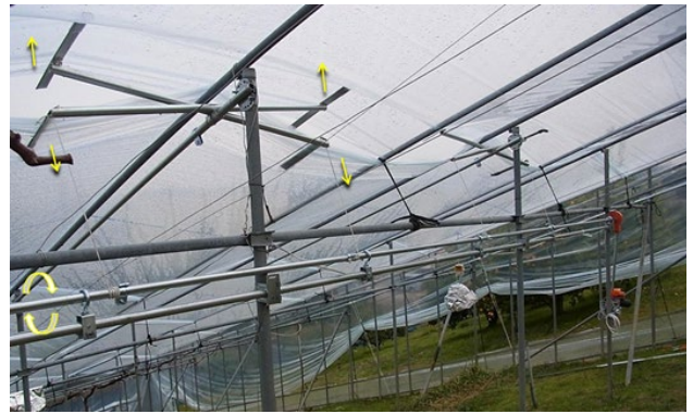
▲天井ビニール開閉装置
