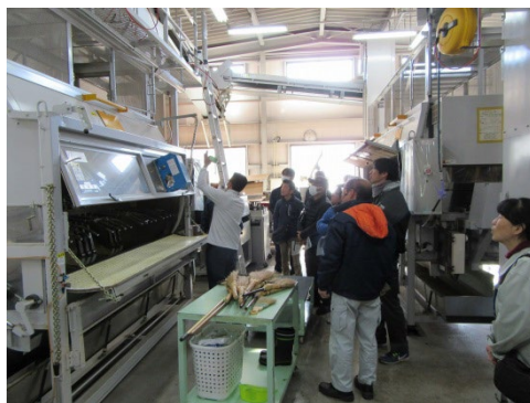
茶工場内の点検
