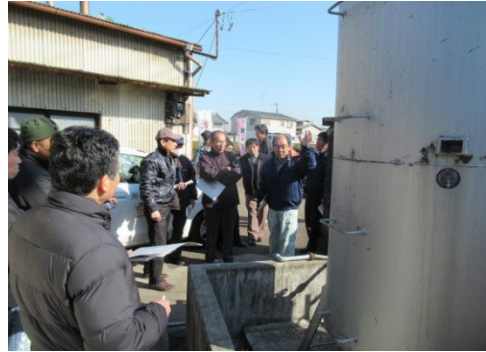
重油タンク・燃料小出槽の点検
