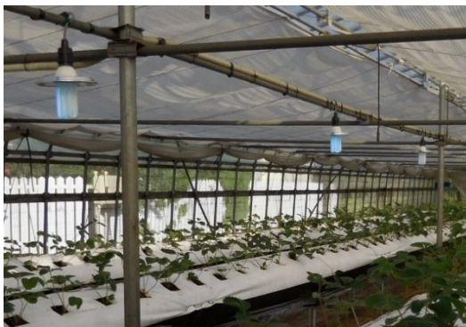
図5 UV-Bライトの設置状況
