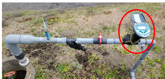
電磁弁（ガルコン）の設置
