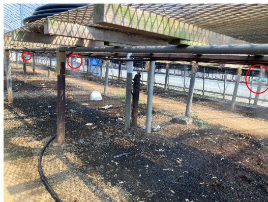
図2 ベンチ下ミスト冷房 ※赤丸内はミストノズル
