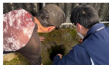
縦穴を覗いて水位を確認
