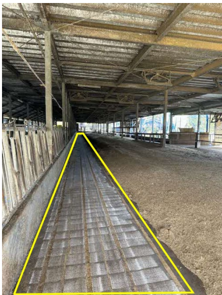
滑り止め (黄色枠部分)
