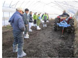
写真2 無材暗きよ施工（カットドレーン mini）の実演
