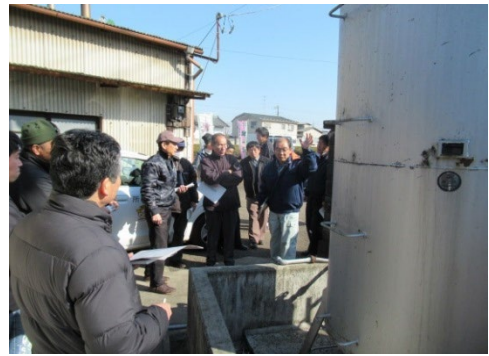
重油タンク・燃料小出槽の点検
