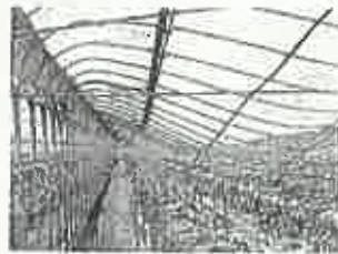
写真-1 被害にあった園芸用ハウス
