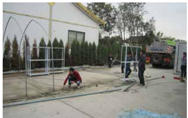
ビニールハウス撤去
