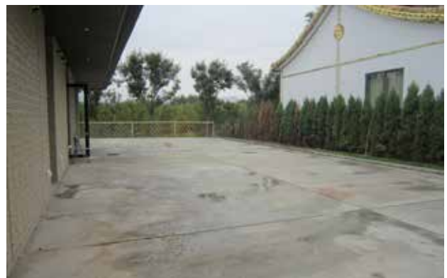
バックヤード撤去完了
