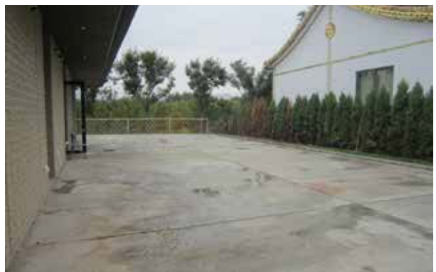
バックヤード撤去完了
