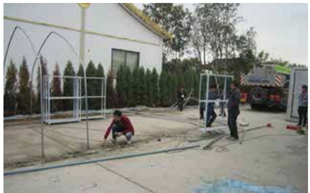
ビニールハウス撤去
