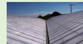
遮熱剤塗布後の施設屋根
