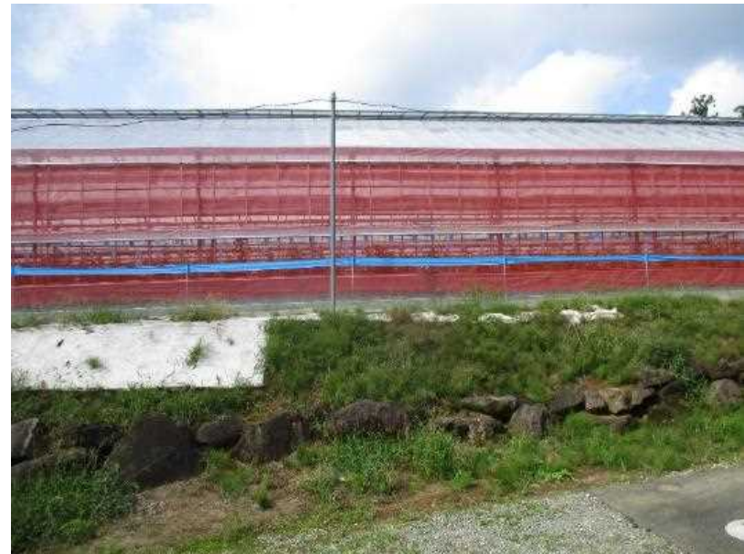
ホリバーロール設置後の様子
