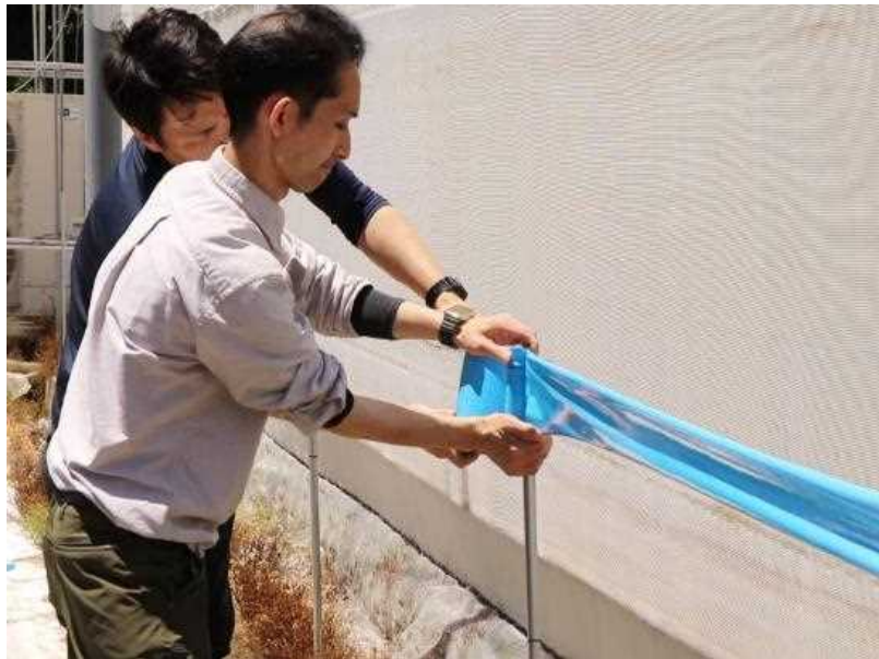
ホリバーロール設置作業
