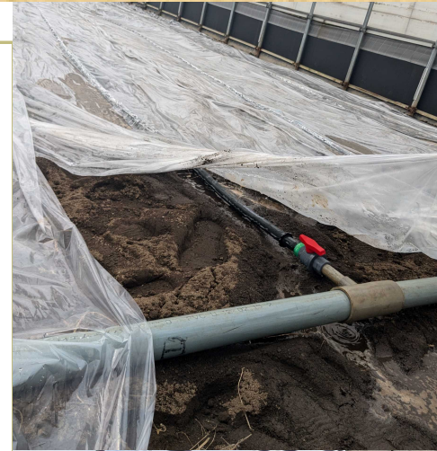
←敷設した散水チューブ
