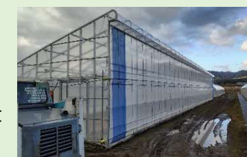
写真：片屋根単管ハウス
