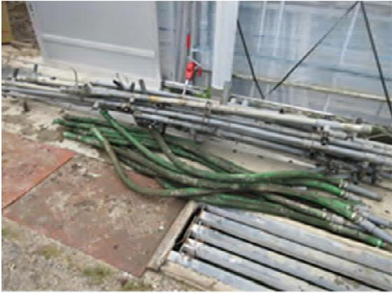
ハウス内高温での塩ビ管変形防止のため外へ
