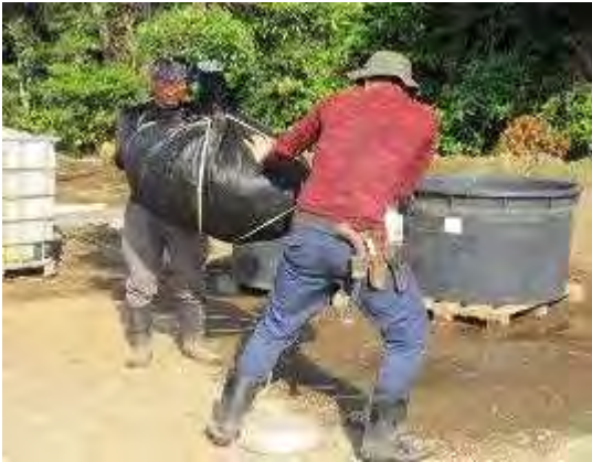
7 遮光資材で被覆、縄かけ
