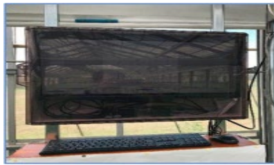
統合環境制御装置
