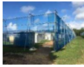
防風ネットの設置
