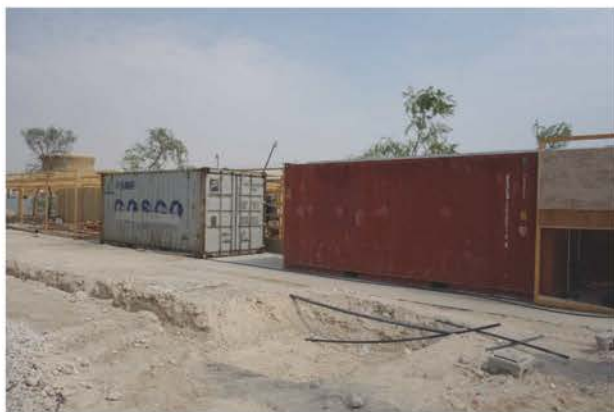
資材コンテナ(左)と保冷コンテナ(右)
