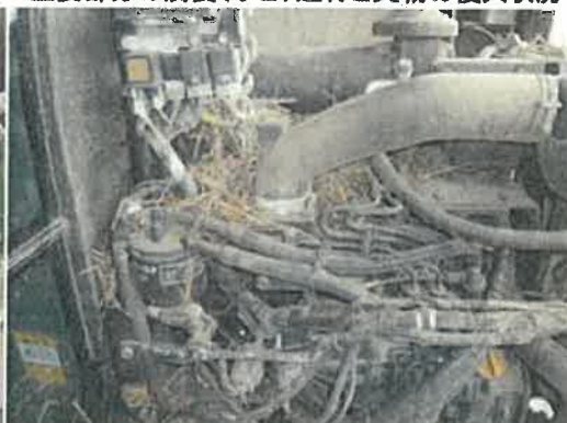
主要部分の腐食(サビ)進行と異物の侵入状況
