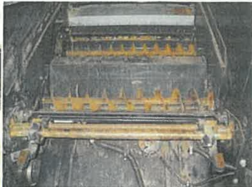
主要部分の腐食(サビ)の進行と泥の侵入状況
