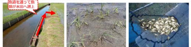
排水路から水田へつながる一筆型魚道
