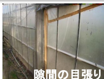
隙間の目張り
