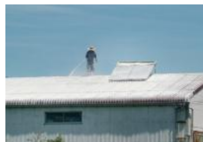
牛舎屋根への石灰乳の塗布
