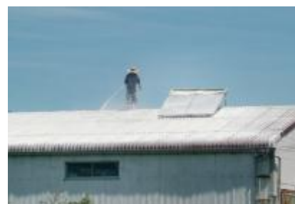
牛舎屋根への石灰乳の塗布
