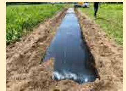
▲太陽光養生熱処理
