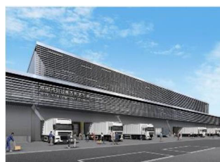
▲成田集荷センター
