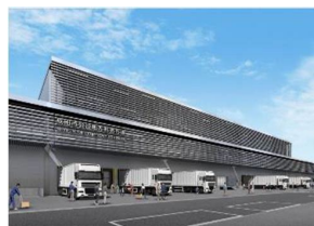
▲成田集荷センター
